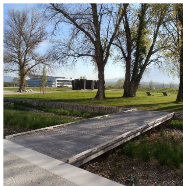
Passerelle bois Bois naturel imputrescible et traité anti dérapage
