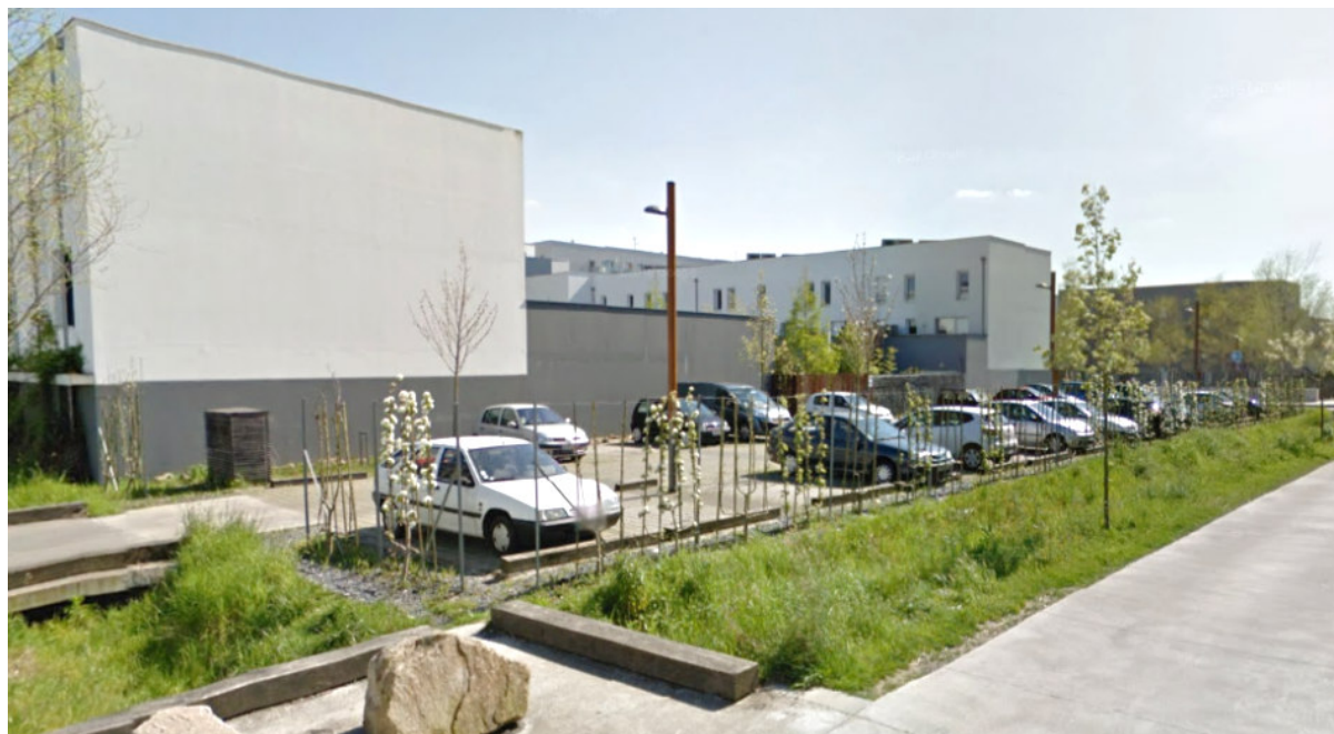
Noue de récupération des eaux pluviales sur les parkings
