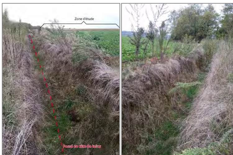
Fossé aménagé en crête de talus, vues depuis la limite nord du projet : vers l'est (gauche), vers l'ouest (droite)
