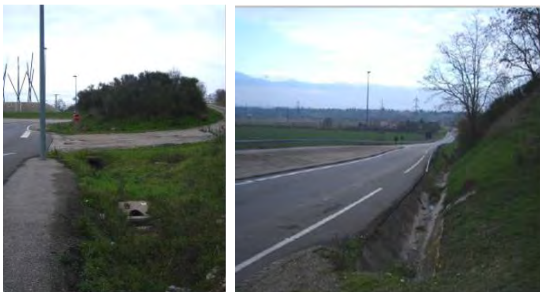
Fossé amont, RD519d et giratoire des Mikados traversée Ø300 (photo de gauche) Coursier en béton coulé, aval du giratoire, RD519d (photo de droite)
