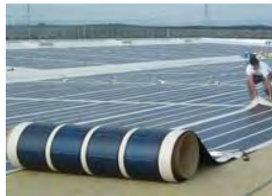
Cellules photovoltaïques intégrées au complexe d'étanchéité pour bâtiment industriels
